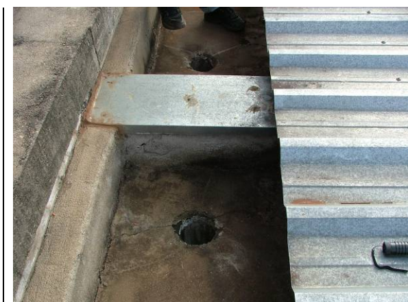
Figura 5. Chapa de aço colocada sobre a junta de dilatação junto a calha
