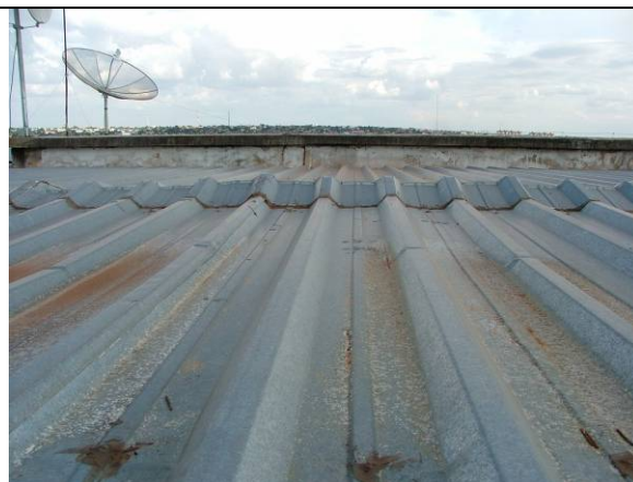
Figura 12. Pontos de acúmulo de água
