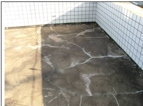
Figura 17. Trincas na laje da entrada
