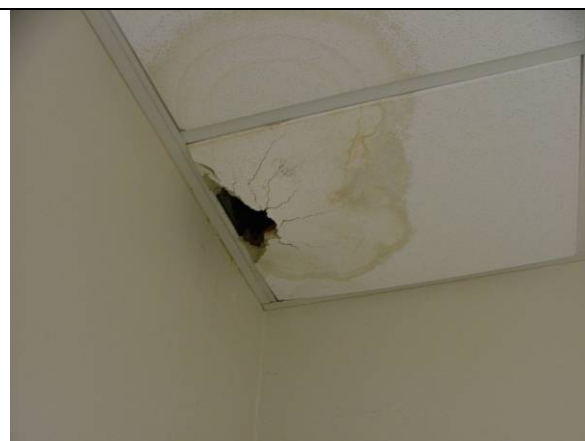
Figura 2. Infiltração na sala NO
