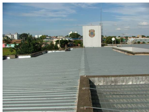
Figura 6. Chapas de aço (rufos) nas faces verticais externas das calhas
