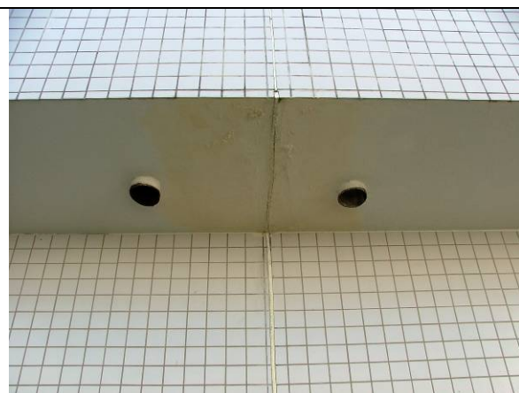
Figura 16. Infiltrações sob a junta
