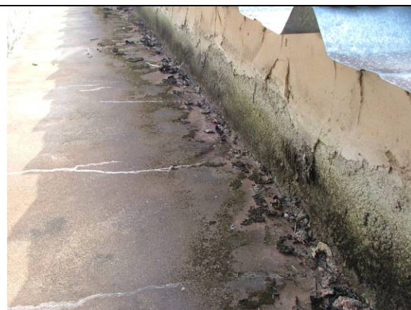
Figura 8. Acúmulo de sujeira e lodo de um lado da calha
