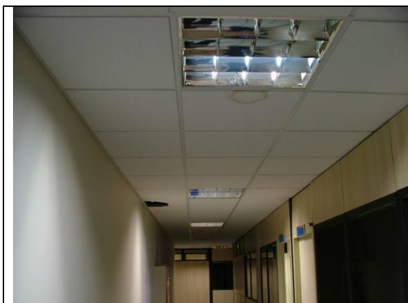
Figura 1. Infiltração no corredor
