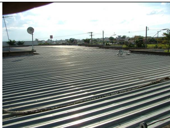
Figura 11. Telhado com pequena inclinação
