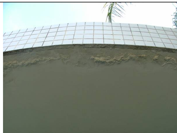
Figura 18. Infiltração no bordo inferior da laje
