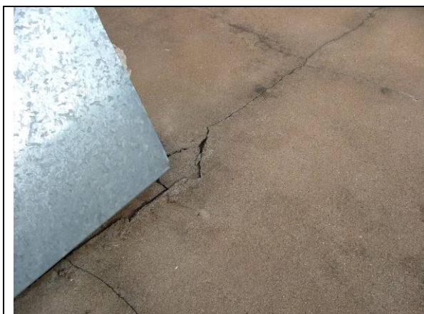
Figura 9. Proteção mecânica soltando
