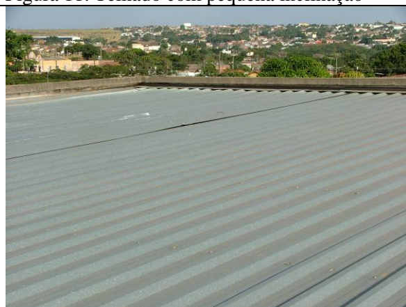
Figura 13. Falha no cobrimento lateral
