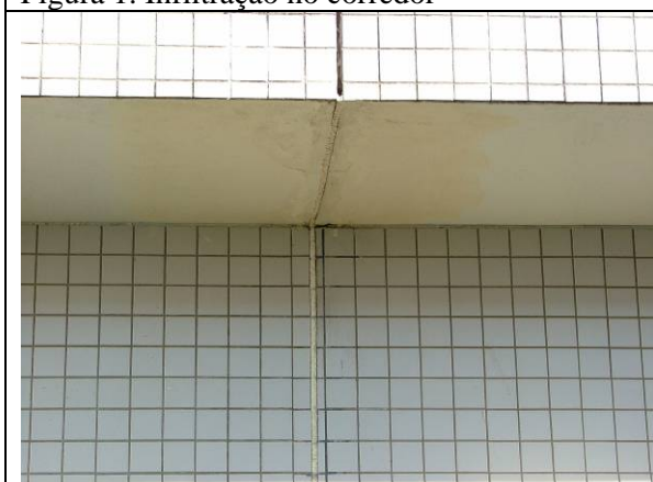
Figura 3. Infiltração externa pela junta de dilatação
