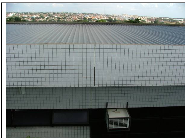
Figura 15. Junta preenchida parcialmente com isopor, sem selante flexível
