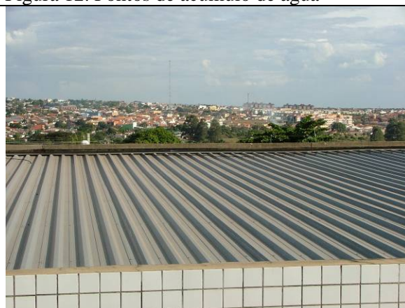
Figura 14. Variações de nível na cumeeira do telhado de uma água
